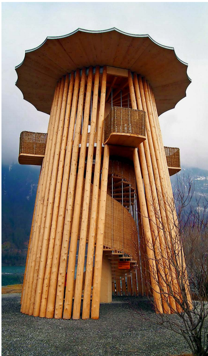
Der neue Turm im Urner Reussdelta.
